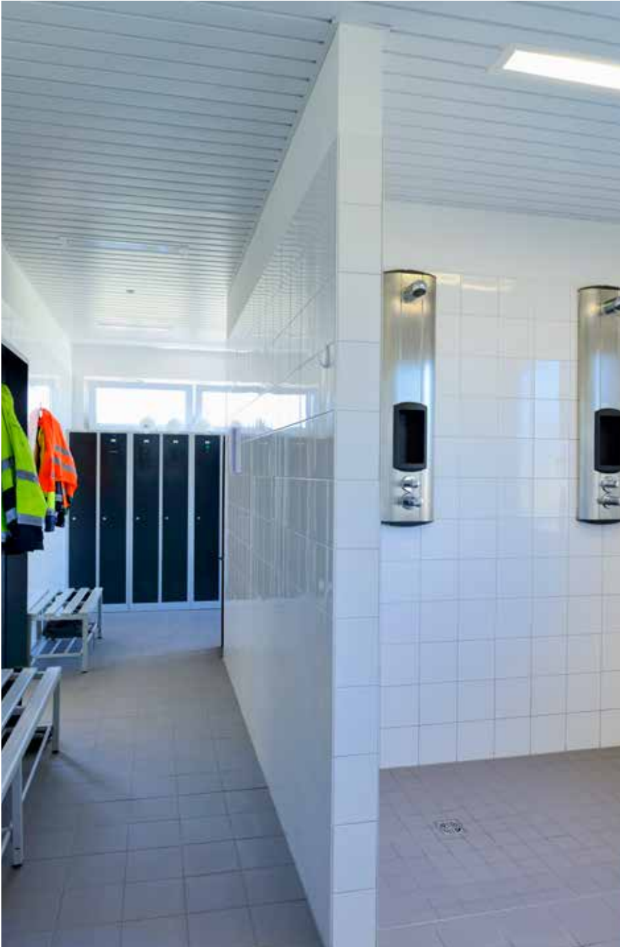
Durchdachtes Konzept: Das Arbeiten mit Erde und Ton verursacht Schmutz. Die Umkleiden sind darum in reine und «unreine» Zonen getrennt, die Duschen befinden sich in der Mitte. Das gewährleistet einen reibungslosen Ablauf nach getaner Arbeit.
