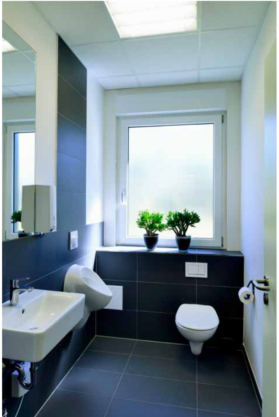
Attraktiv ausgestattet sind auch die Sanitärzonen. Bei der Modulbauweise werden diese bereits im Werk soweit als möglich vorgefertigt und inklusive Sanitärausstattung und Fliesen auf der Baustelle als fertige Module montiert.
