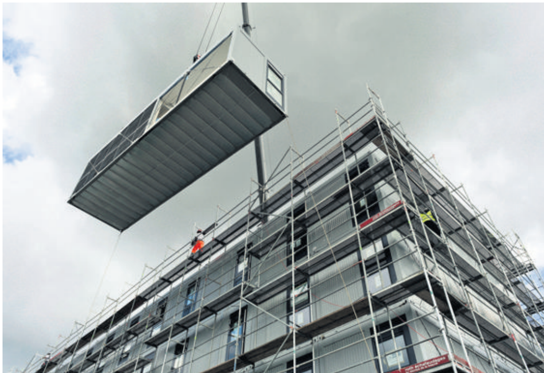
Les travaux ont débuté en mai et se termineront à la fin de décembre. LAURENT GUIRAUD
